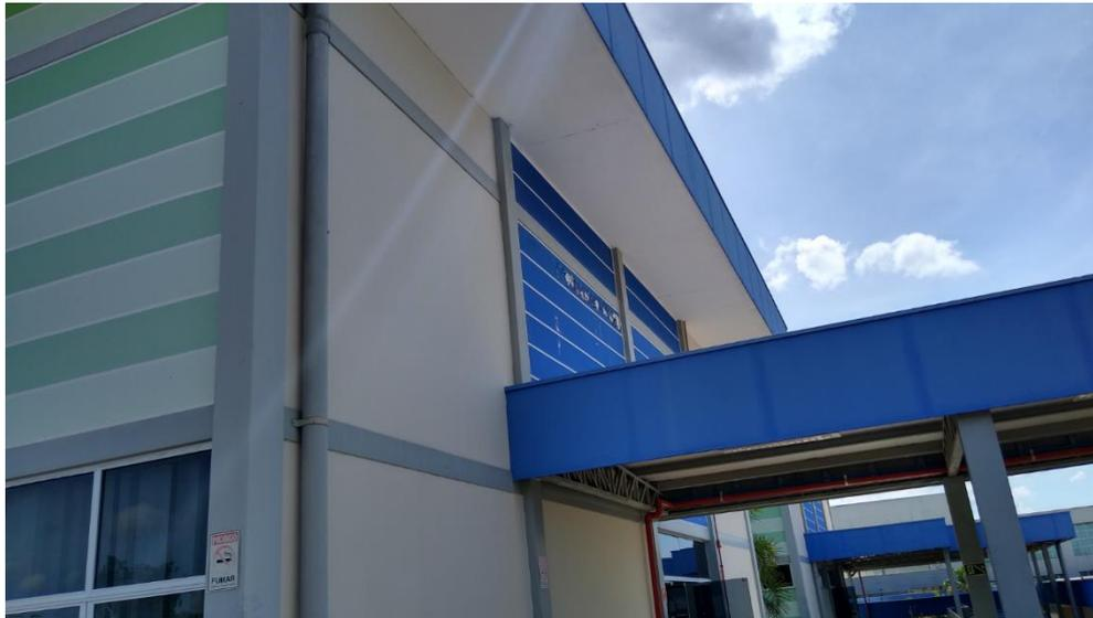
Figura 6 –Platibandas com aplicação de textura acrílica e pintura em tinta acrílica na cor azul SENAI.
